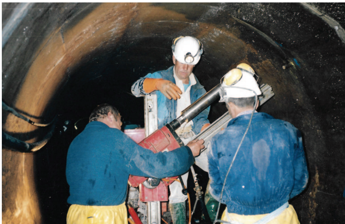
Une équipe de sondeurs utilisant une foreuse ou carotteuse (2000).
